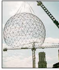
Pose de la Coupole du musée Dali à Figueras
